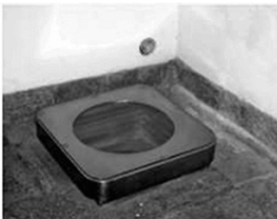
Figura 9 En el hall del Cabildo de Montevideo podemos observar una esfera metálica cuya parte superior materializa el origen (Datum) de referencia altimétrica.
